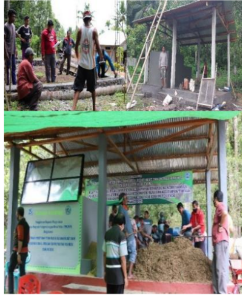
Gambar 1. Proses Pembangunan Rumah Kompos
