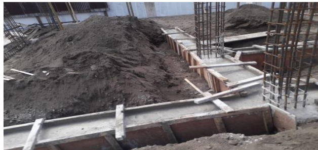
Gambar : Pengerjaan Slot Bawah
