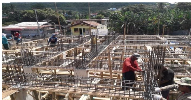
Gambar : Perakitan Besi Untuk Plat Lantai
