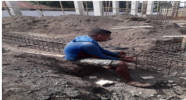
Gambar: pekerjaan perakitan besi
