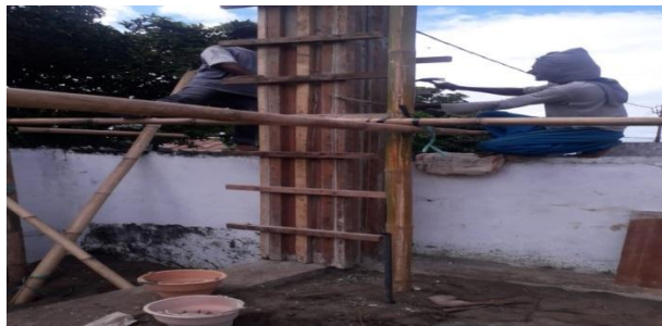
Gambar : pekerjaan bekisting konvensional
