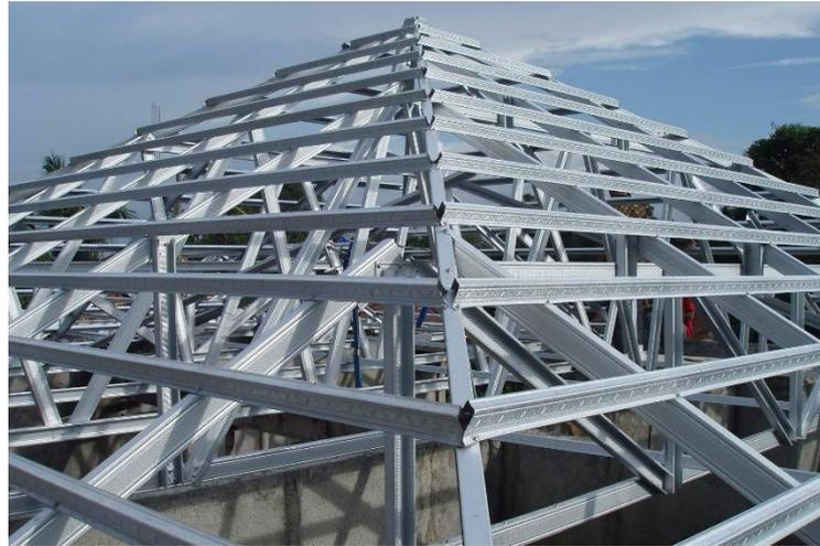
Gambar 5.47 : Rangka atap baja ringan
