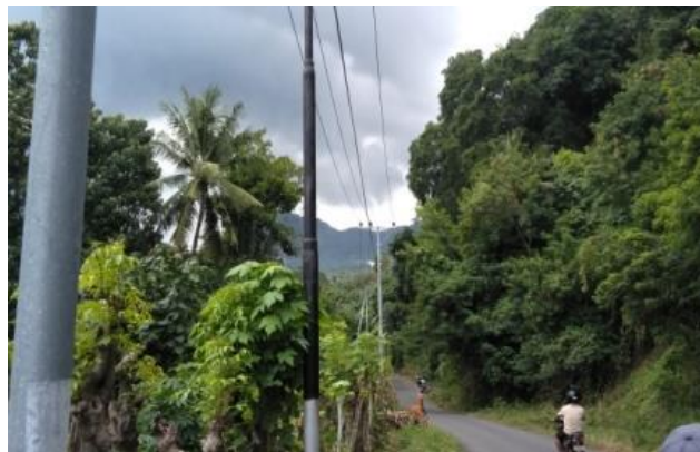
Gambar 4.17 Tiang Listrik (Sumber: Dokumentasi Penulis, 2023)
