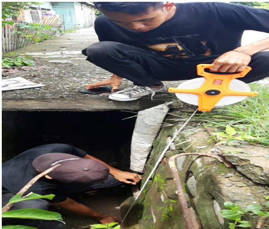
Gambar L2 : Pengukuran tinggi saluran drainase jalan Moh.Hatta
